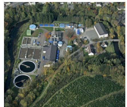
Bild 2: Kläranlage Krummenohl des Aggerverbandes. © Aggerverband
