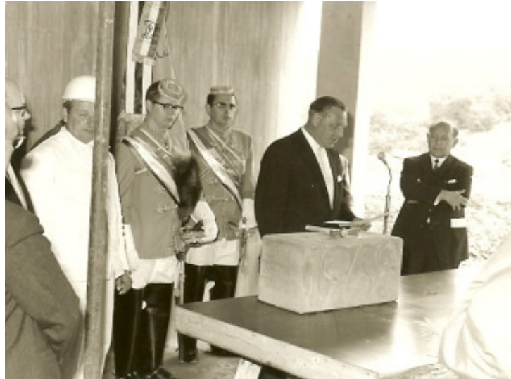
Baudirektor Bethge bei der Grundsteinlegung, Juni 1968
