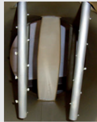
Abb. 8: Dosierlanzen nach Änderung der Austrittsöffnung (1,5 mm), Betrieb sechs Monate
